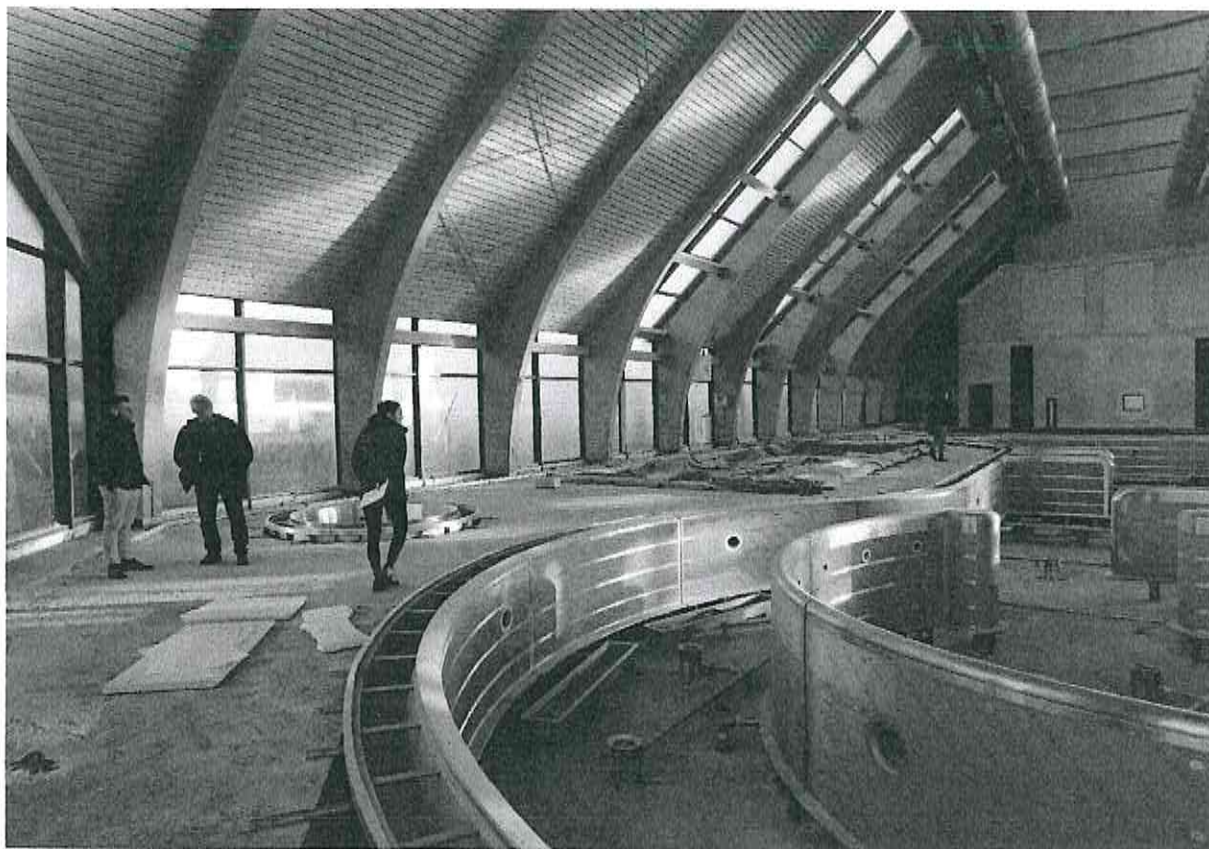
Fot.9. Część basenowa
