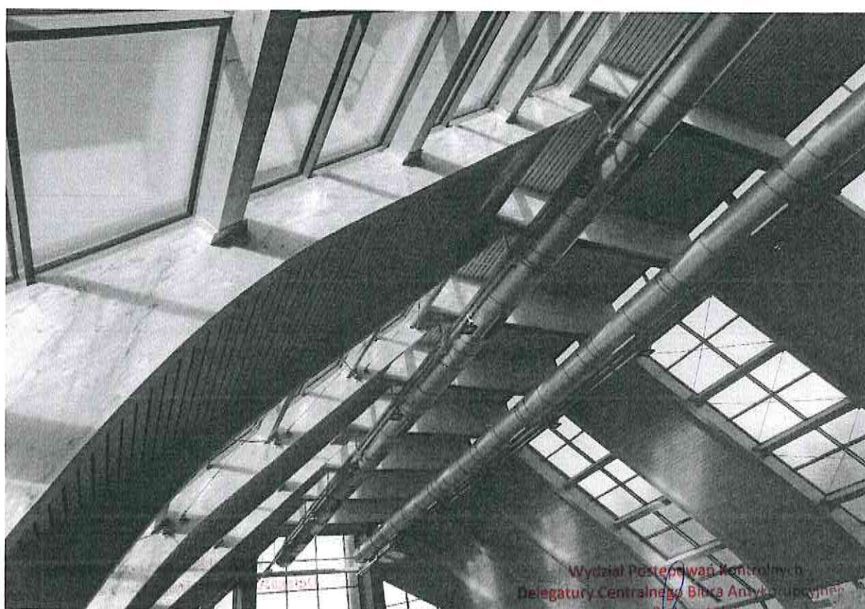
Fot.16. Część basenowa
