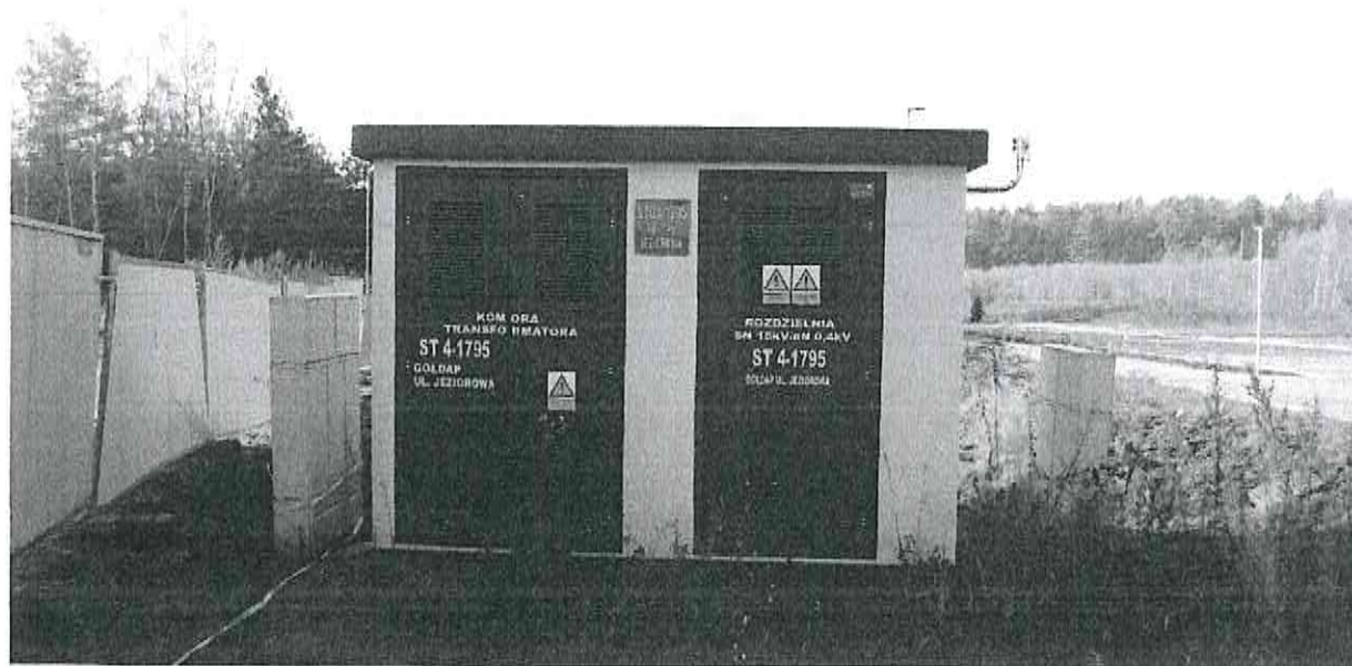
Fot.72. Stacja trafo 15/0,4 oraz złącze kablowo pomiarowe budynku (po lewej)
