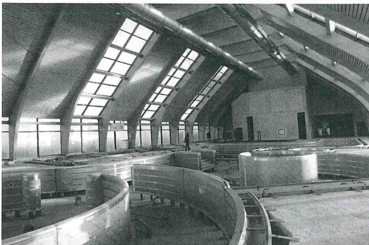
Fot.11. Część basenowa
