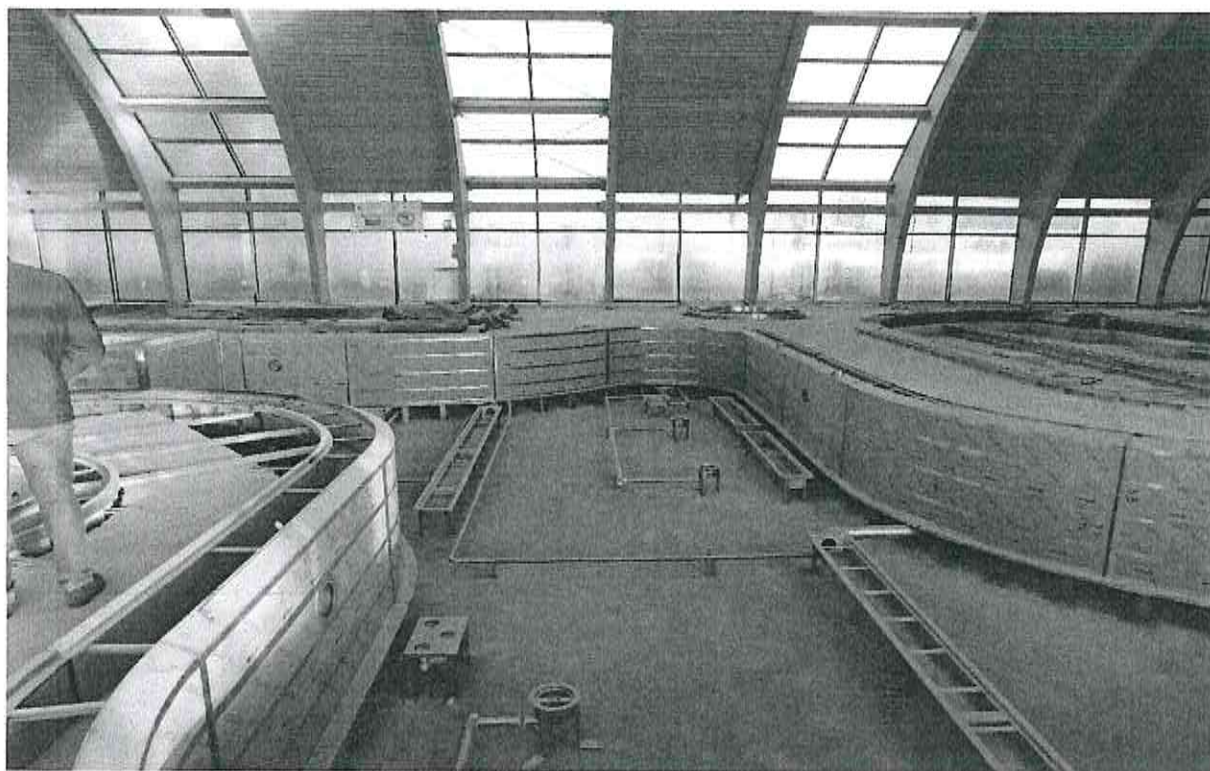
Fot.15. Część basenowa
