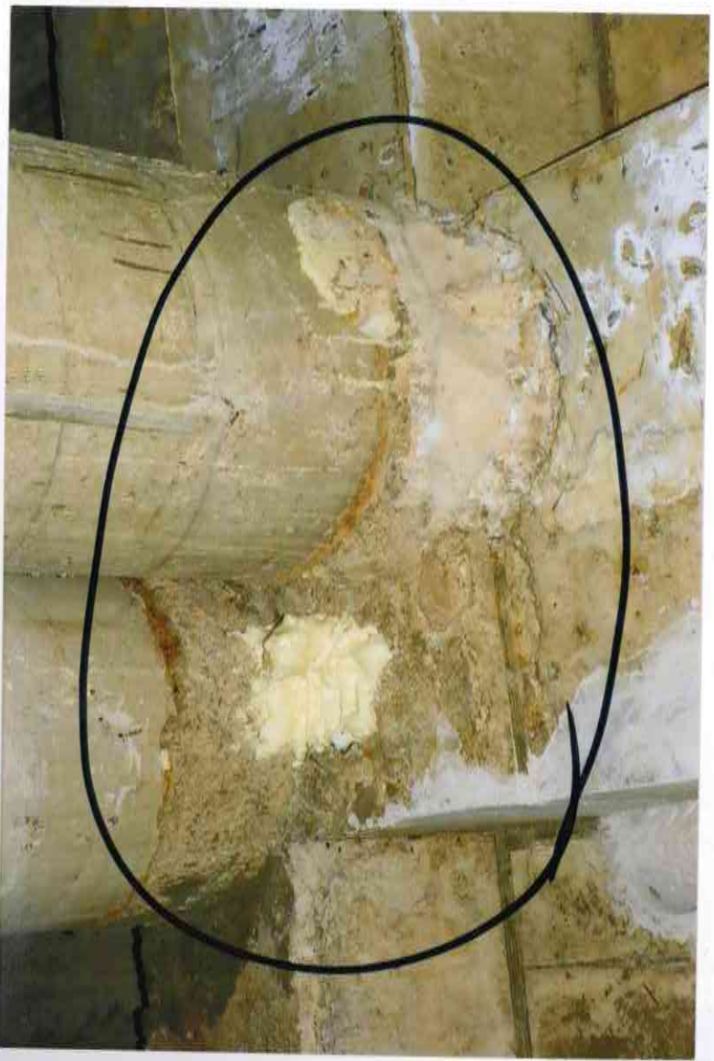
Zbliżenia wady wykonawczych słupów podporowych stropu nad podbaseniem.
