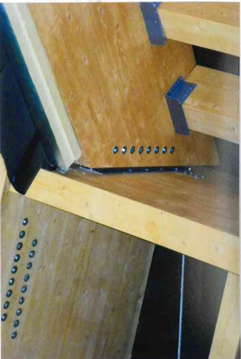
Zbliżenie elementów drewnianych na poddaszu.
