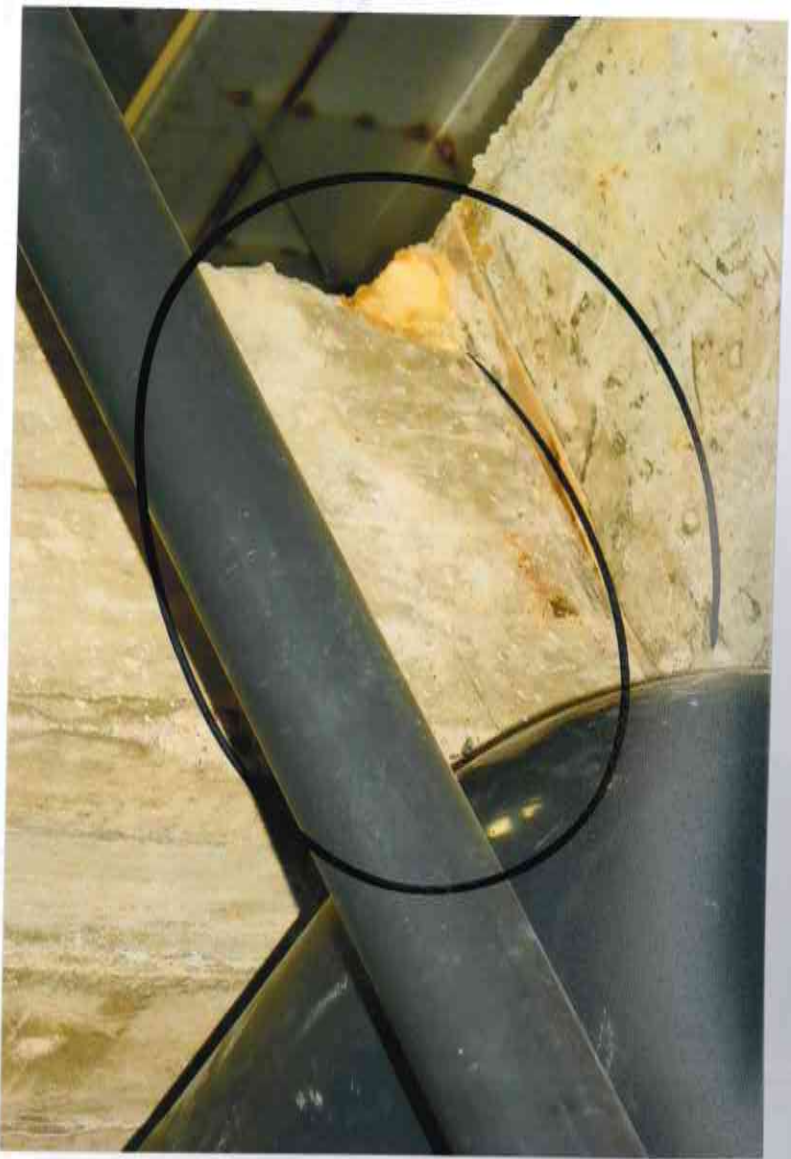
Zbliżenia wadliwego przygotowania deskowania stropu i ścian.
