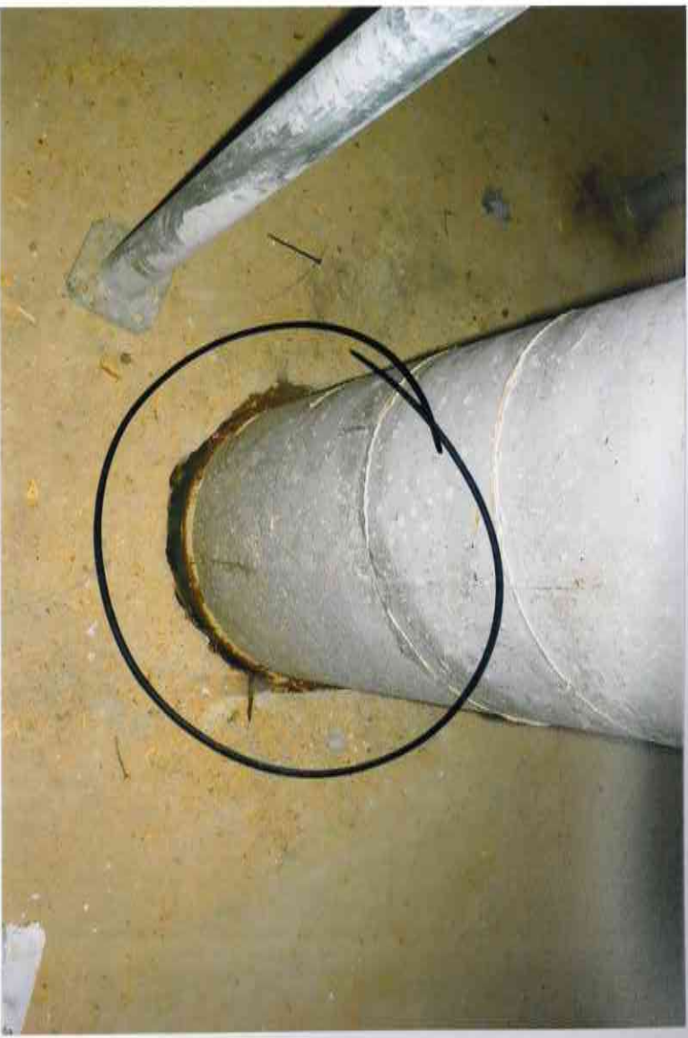
Brak możliwości zweryfikowania osadzenia słupów w stopach.
