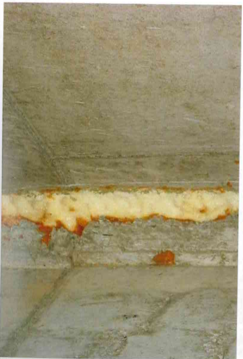
Próba " doszczelnienia " narożnika pianką poliuretanową.
