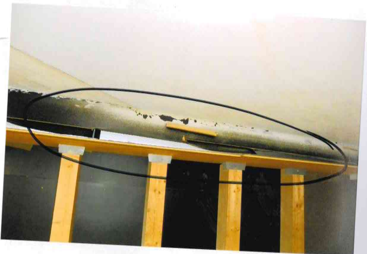
Zbliżenie osadzenia słupów drewnianych na poddaszu.
