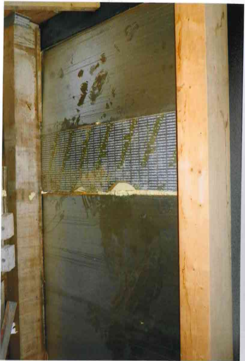
Zbliżenie zamiennego rozwiązania izolacji termicznej dachu.
