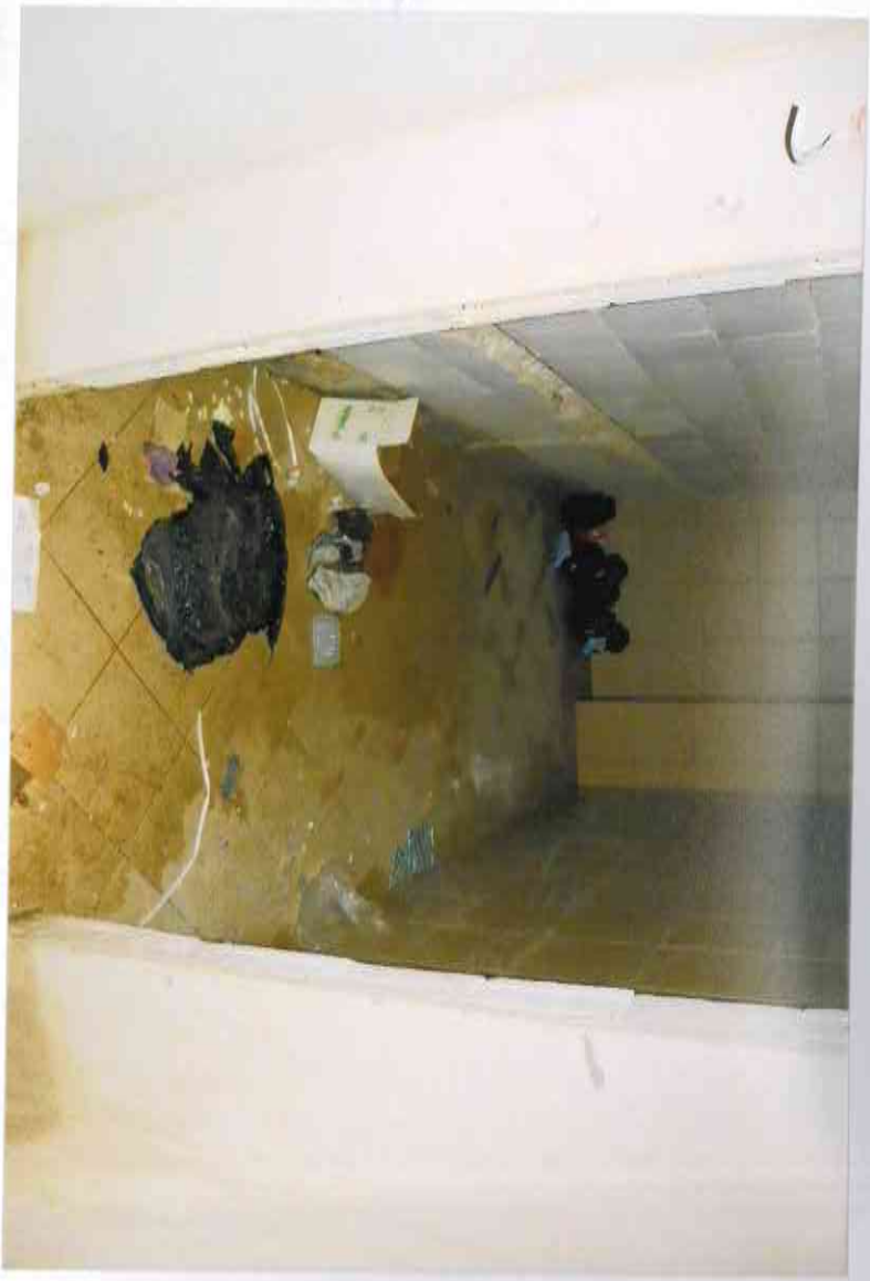
Widok na pomieszczenia na parterze budynku.
